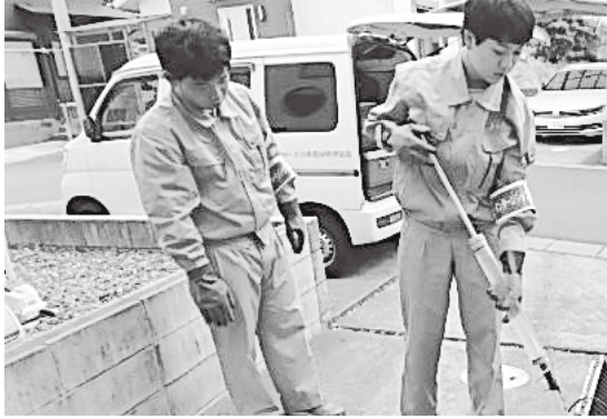
法定検査の様子
