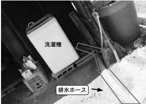
① 洗濯機の未接続
