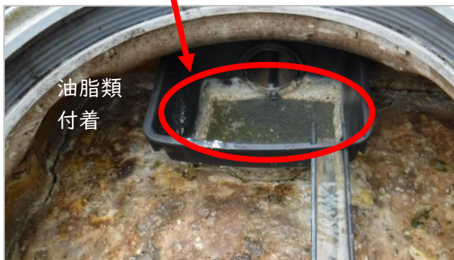
流入管きよへ油脂類付着
