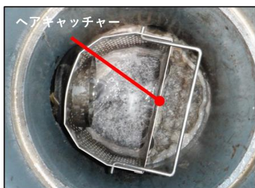
写真5 ヘアキャッチャー設置状況
