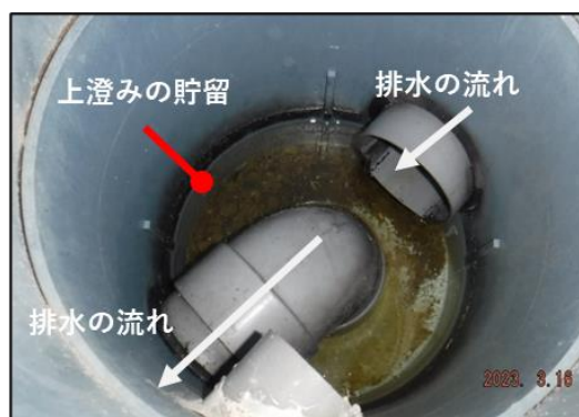
写真6 エルボ管設置状況
